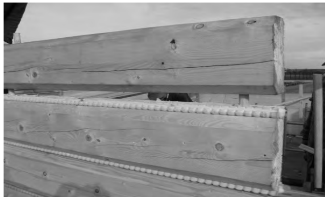
Rys. 3. Łączenie bali na kołki (dyble), (fot. autorki)
