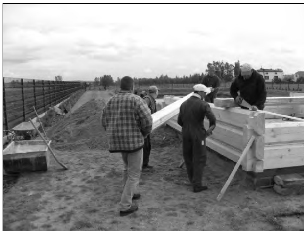
Rys. 2. Ułożenie ścian z bali na węglach z zastosowaniem ostatków (fot. autorki)
