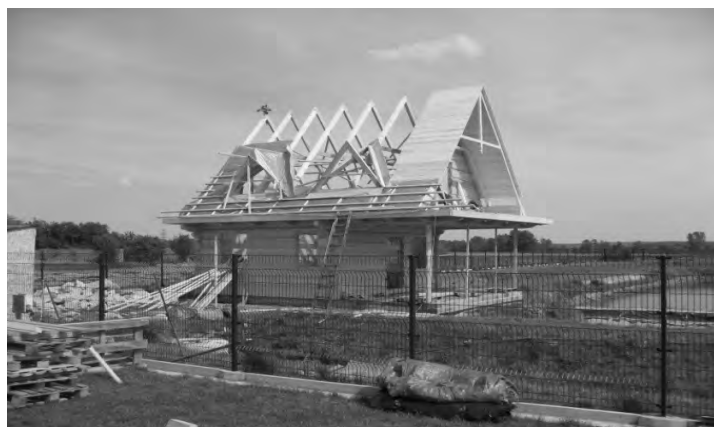
Rys. 5. Wieżba dachowa jętkowa (fot. autorki)
