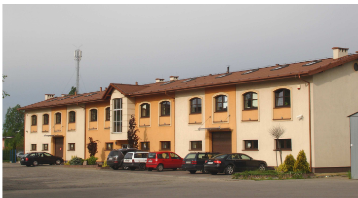
Rys. 4. Widok budynku od strony południowo-wschodniej
