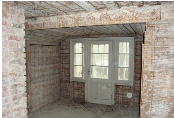
Fot. 3. Wnętrze budynku. Widoczna struktura budowlana drewnianych ścian konstrukcyjnych i drewnianego stropu [1]
