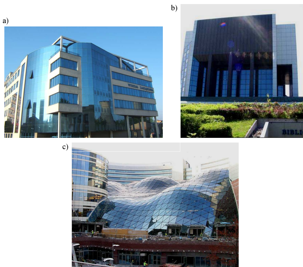
Rys. 1. Przykłady budynków ze szklanymi przegrodami: a) Wydział Zarządzania Politechniki Częstochowskiej, b) Biblioteka Śląska w Katowicach, c) Złote Tarasy w Warszawie [1]
