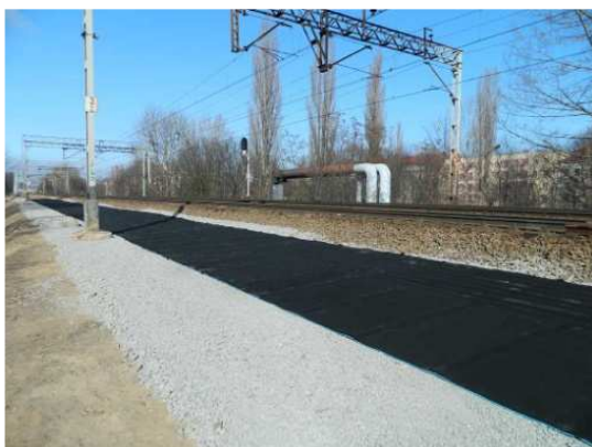
Rys. 3. Maty wibroakustyczne pod torowisko kolejowe [10]
