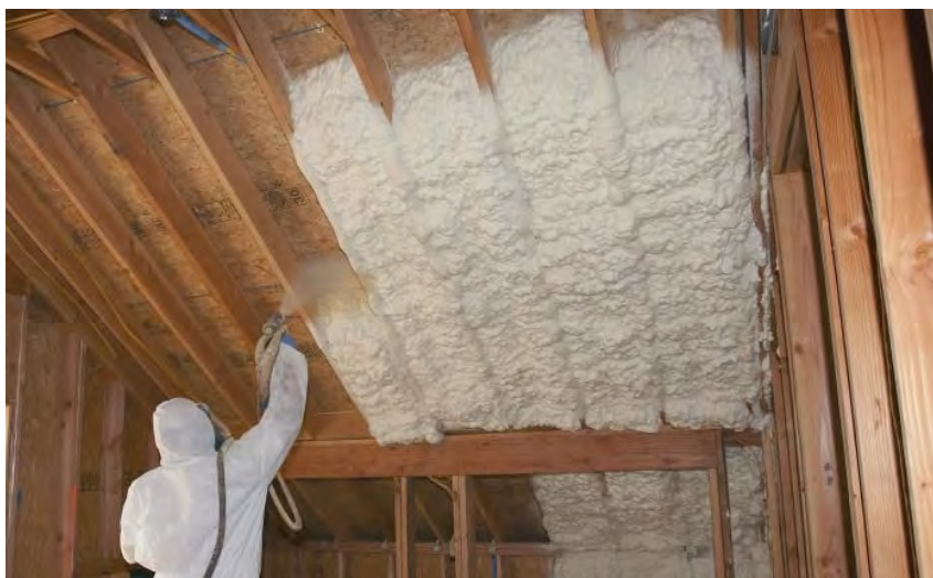
Rys. 1. Natryskiwanie pianki poliuretanowej [3]
