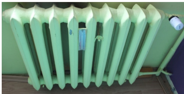
Rys. 1. Sposób zamocowania podzielnika [fot. własna]
